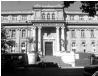
Fachada del Hospital Pedro de Elizalde, ex Casa de Niños Expósitos.
