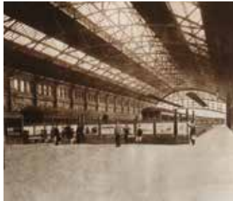
Interior de la Estación Once, Ciudad de Buenos Aires. Fototeca Benito Panunzi. Biblioteca Nacional.
